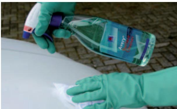
5. Reinigen Sie die Oberfläche mit Avery Surface Cleaner bevor Sie mit einem neuen Verklebepvorgang beginnen.
