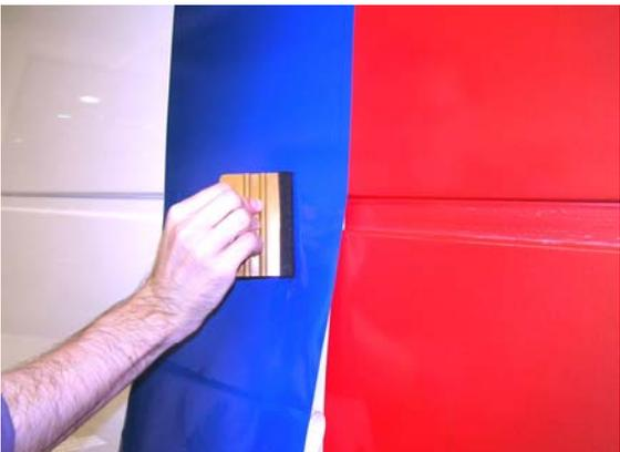
Verwenden Sie **besondere Sorgfalt** beim Nachtempern der Überlappungen in Vertiefungen. **Erwärmen Sie diese Stellen auf 120°C**.
